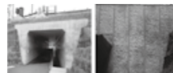
カルバートボックス壁面(スリット)の例▶P.39
